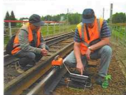
Рис. 5. Работа с дефектоскопом АВИКОН-17 в пути
